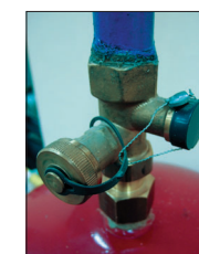
Многофункциональная арматура для расширительного бака
