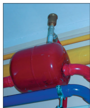
Воздухоотделитель заводского исполнения с автоматическим и ручным воздухоотводчиками
