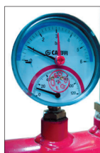
Термоманометр на выходе котла
