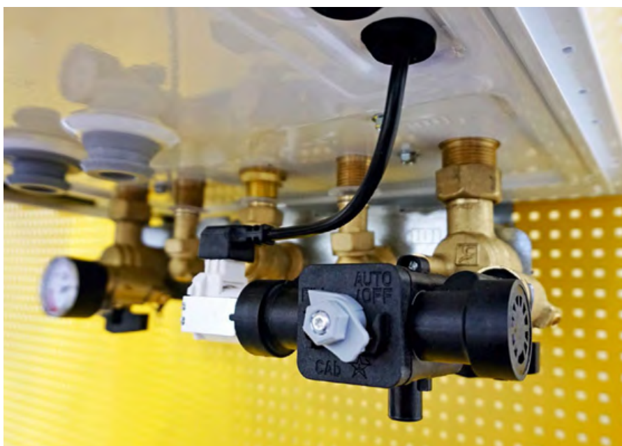
❖❖ Клапан автоматической подпитки системы Active Refill Technology на котле
